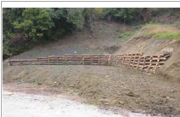
Immagine dello sbancamento della collina per ricavare lo spazio per il nuovo ristoro
